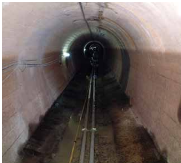
長距離トンネル圧送状況
