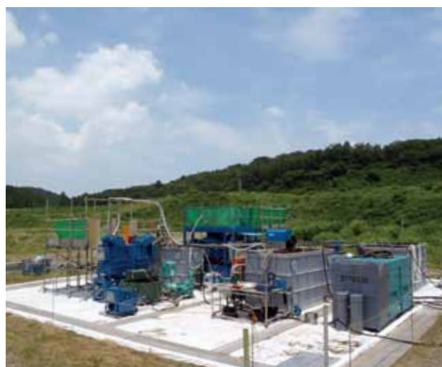
注入プラント設置状況
